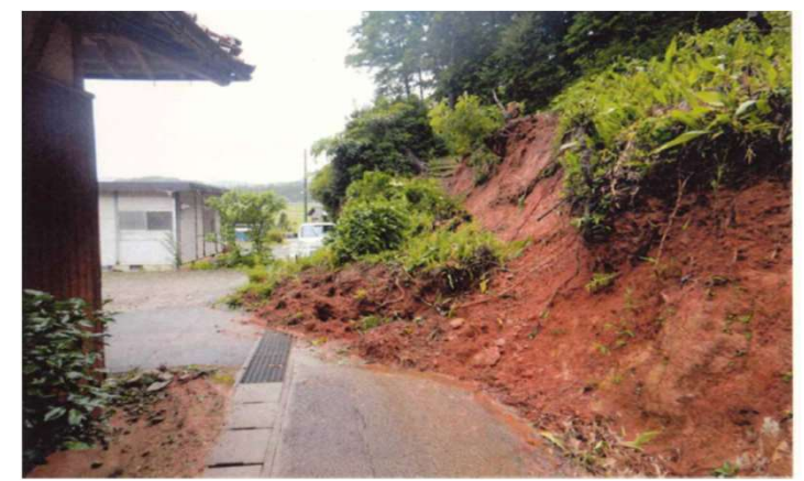
どいしき 土井敷薦津線法面崩落（下佐陀町）
